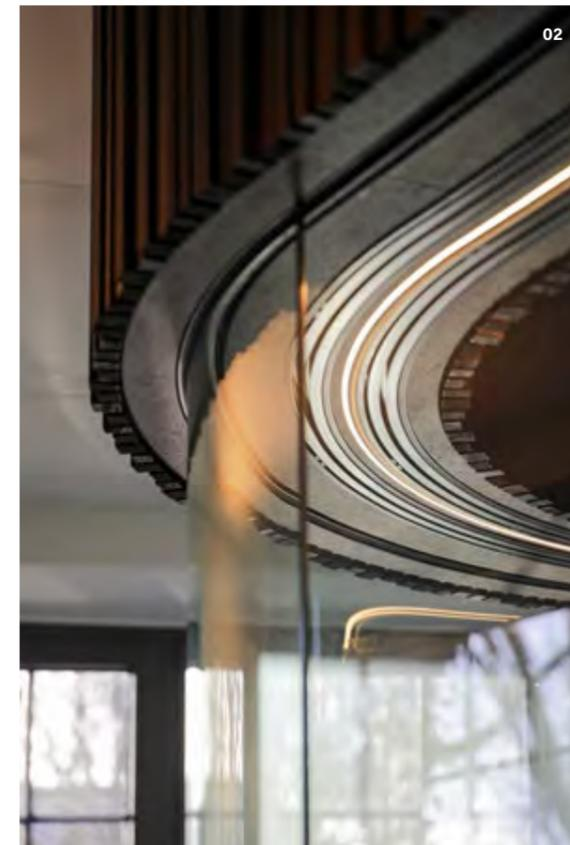
**01** Dank der elektrifizierten Vorhänge kann die Glaskabine spielerisch leicht optisch separiert werden. **02** Die aufwendige Deckenkonstruktion fasst die Glaselemente und Stoff-Schienenprofile ein.
